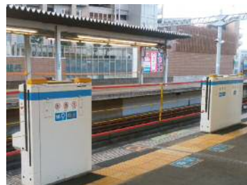
ホームドア（昇降式ホーム柵・六甲道駅）
