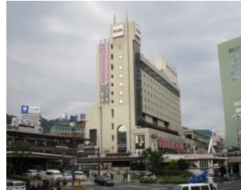
建替を検討しているJR駅ビル
