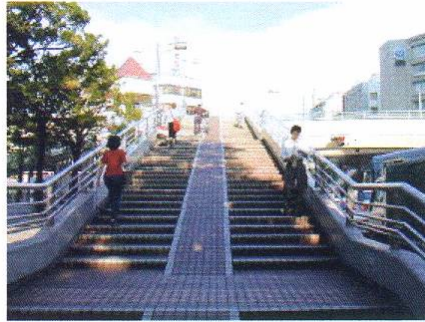
写真3-7-1 有効幅員の確保された斜路付き階段の例
