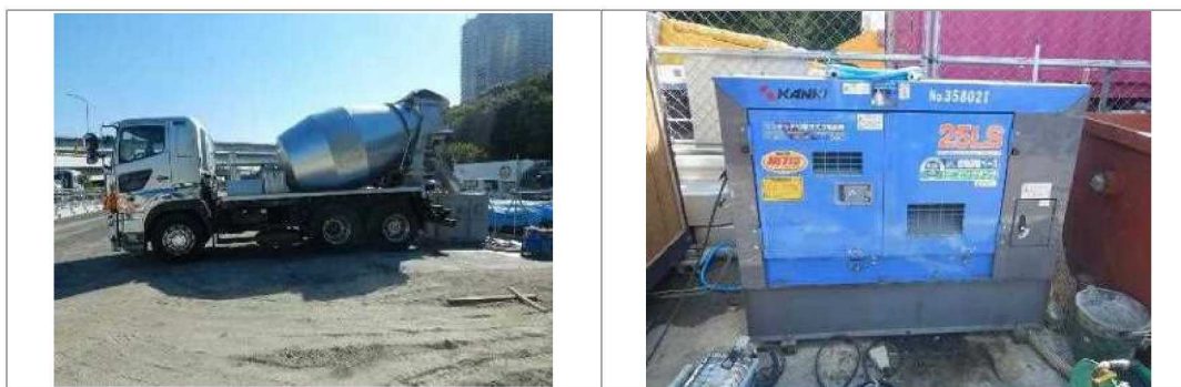
図 5-3 建設機械の稼働状況
