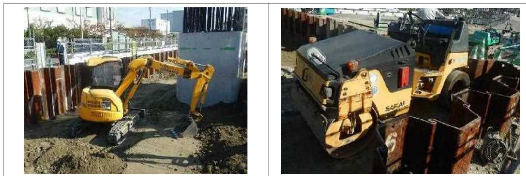
図 5-9 建設機械の稼働状況
