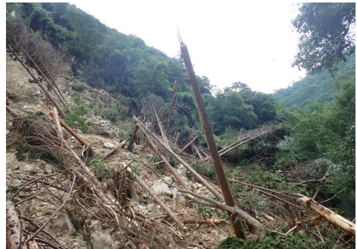
被害の状況（斜面崩壊・トウエンティクロス）
