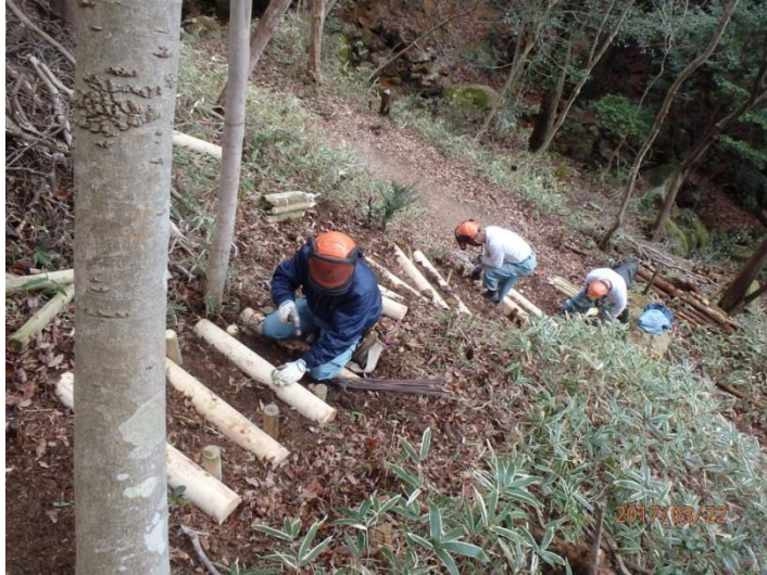
間伐材を活用した階段の整備
