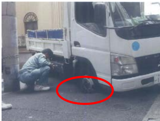
污水管の老朽化で陥没事故発生 (H26. 4)
