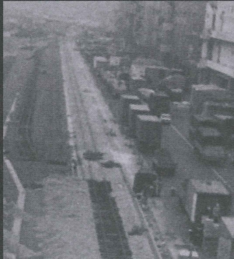
工事中の摩耶埠頭駅(昭和46年)
