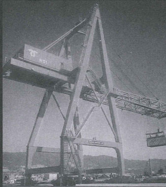
日本初のコンテナクレーン(昭和42年)
