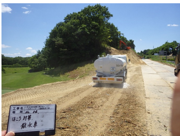
図 4-3 粉じん対策（散水車）
