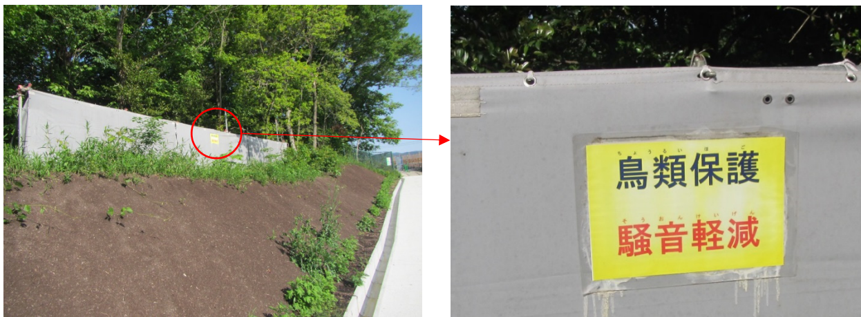
図 4-17 遮音シート設置状況
