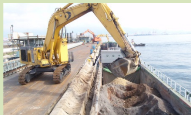
土砂落下防止シートにより陸揚げ時の廃棄物の海中への落下を防止
