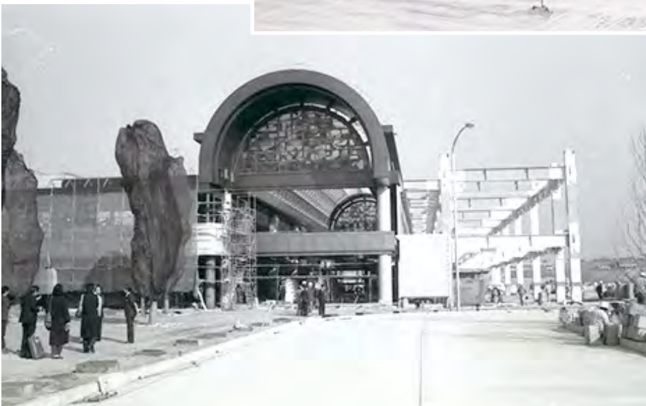
完成間近の西神中央駅 (昭和62年)
