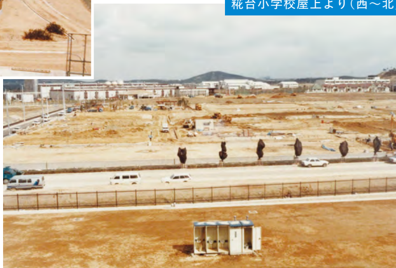
糀台小学校屋上より(西～北)
