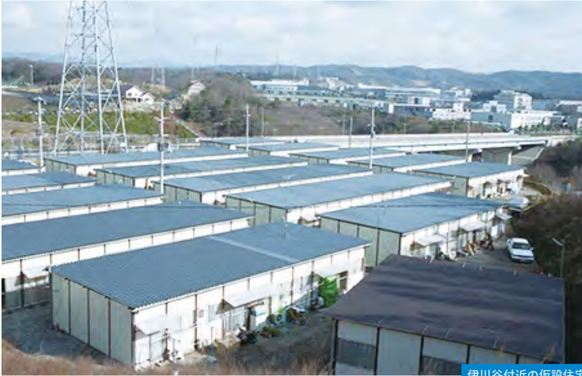
伊川谷付近の仮設住宅
