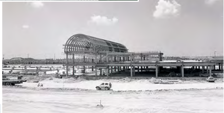
建設中の西神中央駅 (昭和61年7月)
