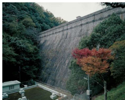
図 57 布引水源地水道施設（五本松堰堤）
