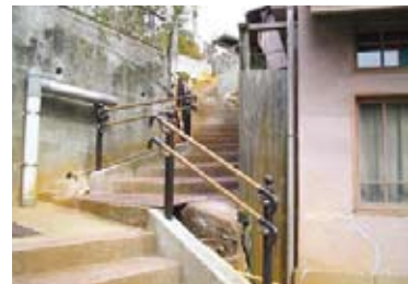
まちの点検による手すりの設置
