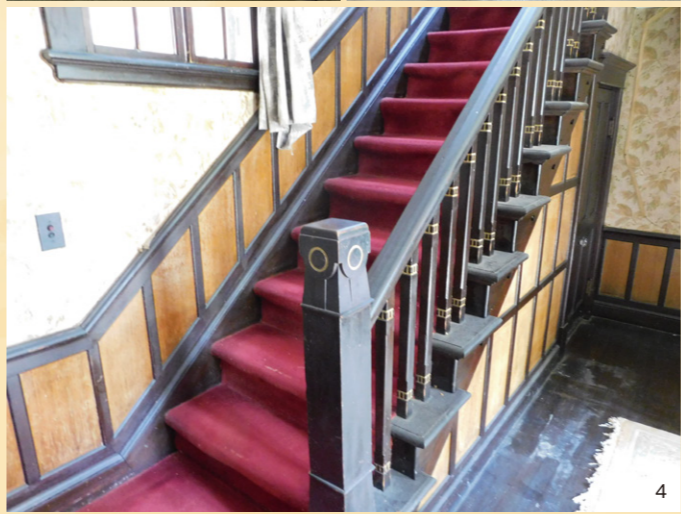
1. 解体される直前の古澤邸。印象的な三角屋根も建築当時のまま 2. 屋根裏に上がると、しっかりした梁(はり)や柱が出現 3. 洋室にあった暖炉。レンガには「大阪産業」の刻印があった 4. 優雅なたたずまいの階段。手すり部分の凝った装飾が美しい。手すりの一部は神戸深江生活文化史料館にて展示している
